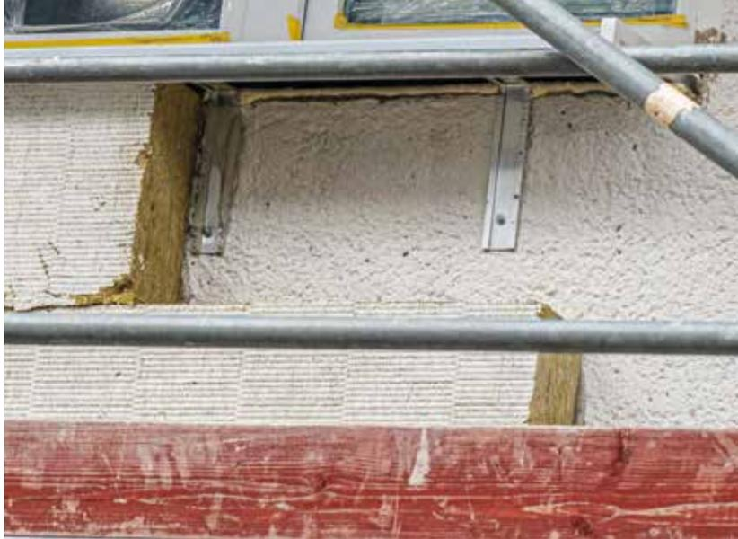
Dieser Blick offenbart die Dicke des Dämmmaterials. Diese besteht im Übrigen aus Mineralfaserstoffen: Hier besteht keine Brandgefahr!
