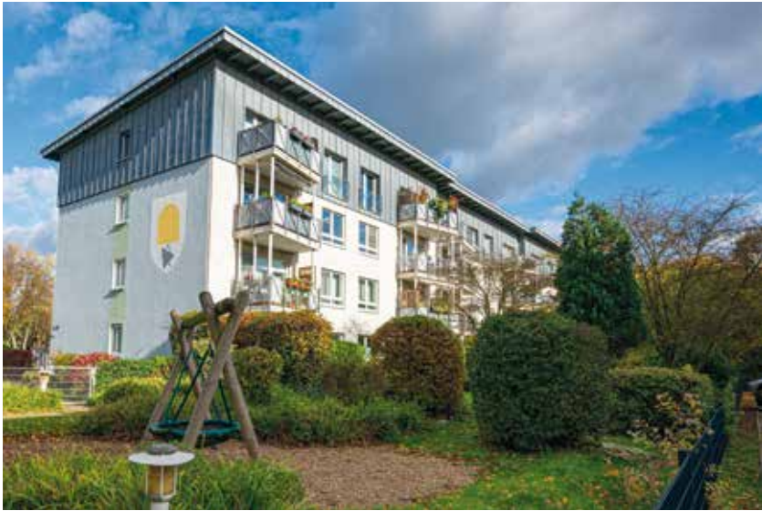
Da die Häuser zwischenzeitlich auch bei der Wärmedämmung modernisiert wurden, kam auch der Einsatz einer Wärmepumpe zur Beheizung in Betracht.
