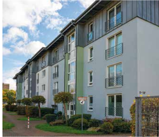
Ein gutes Vierteljahrhundert bestehen die Bauten an der Ährenstraße. Nun war die Gasheizung des WOG-Mitte Wohnblocks sanierungsbedürftig.
