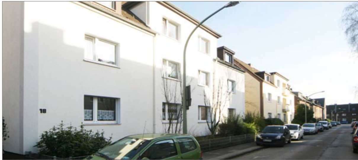
Unsere frisch instand gesetzten Wohnarbeiten in der Ruhrau, Meidericher Straße und Zanderstraße
